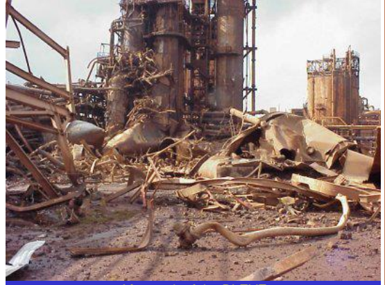
Aftermath of the BLEVE
