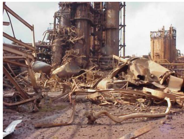
Aftermath of the BLEVE
