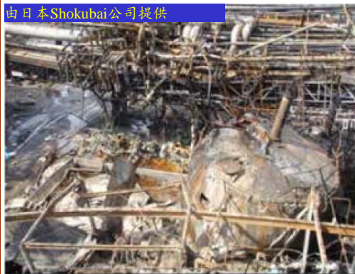
图片1：损毁的AA贮罐
