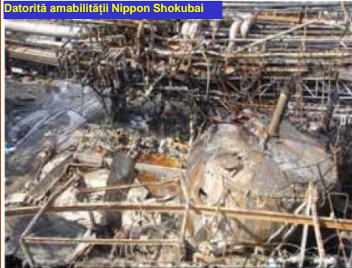
Foto 1: Rezervorul de AA avariata
