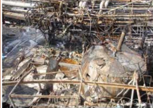
Foto 1: Serbatoio AA distrutto
