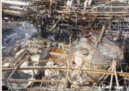
Photo 1: Bac d'acide acrylique détruit
