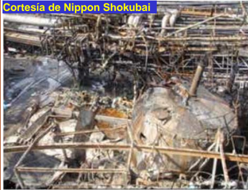
Foto 1: Tanque de AA destruido
