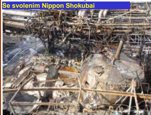
Foto 1: Zničená nádrž kyseliny akrylové
