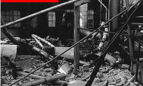
Figura 2: Tubulação rompida
