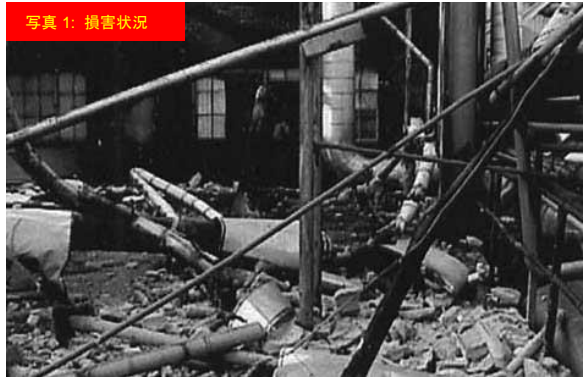
写真 2: 破損配管
