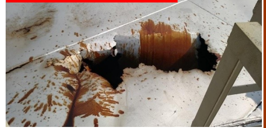
Resim 3: Sıcak yağ tankı tepesinde delik
