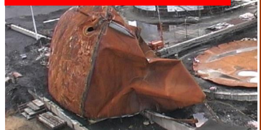
รูปที่ 2 : ถังเก็บน้ำมันที่ร้อน
