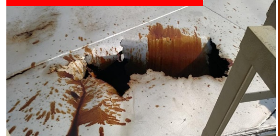
Fig32 : Gaura de pe capacul rezervorului
