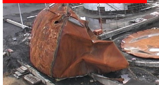
Fig.2 : Tanques de hidrocarbonetos quentes
