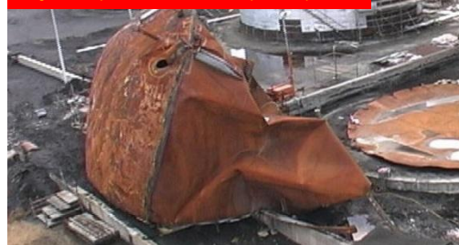
Fig. 2: Tanques contendo hidrocarbonetos quentes
