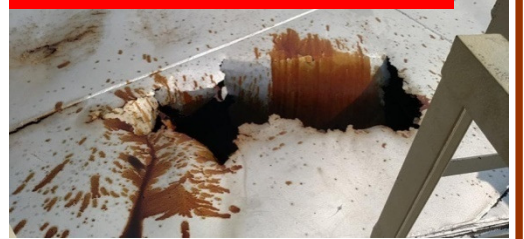
चित्र 3: गरम तेलाच्या टाकीच्या छतामधील छिद्र
