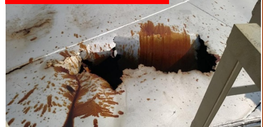
그림 3: 열매유 저장 탱크 지붕의 구멍
