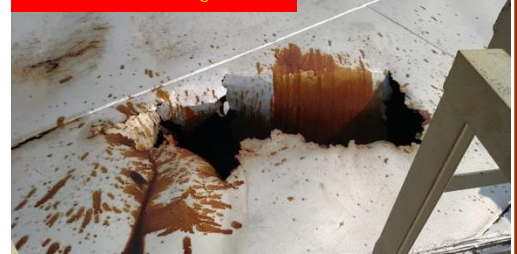
चित्र 3: गर्म तेल के छत में सुराख
