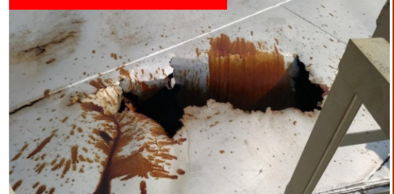
Bild 3: Loch im Tankdach
