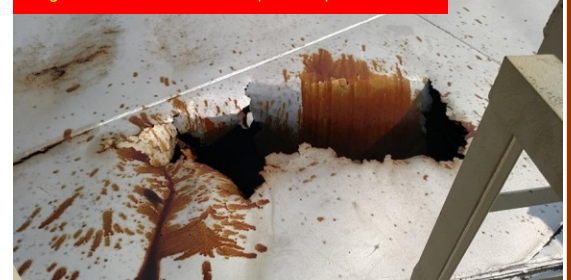
Fig. 3: Forat al sostre d'un dipòsit de petroli calent
