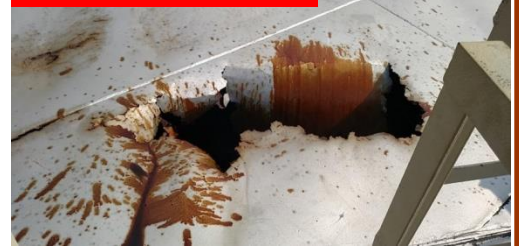
الشكل 3: حفرة في أعلى خزان الزيت الساخن
