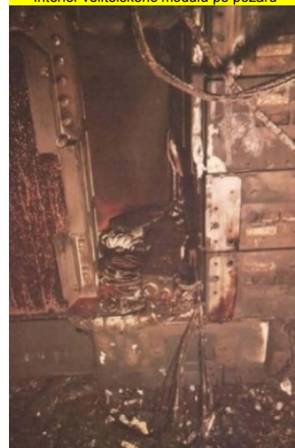
Interiér velitelského modulu po požáru
